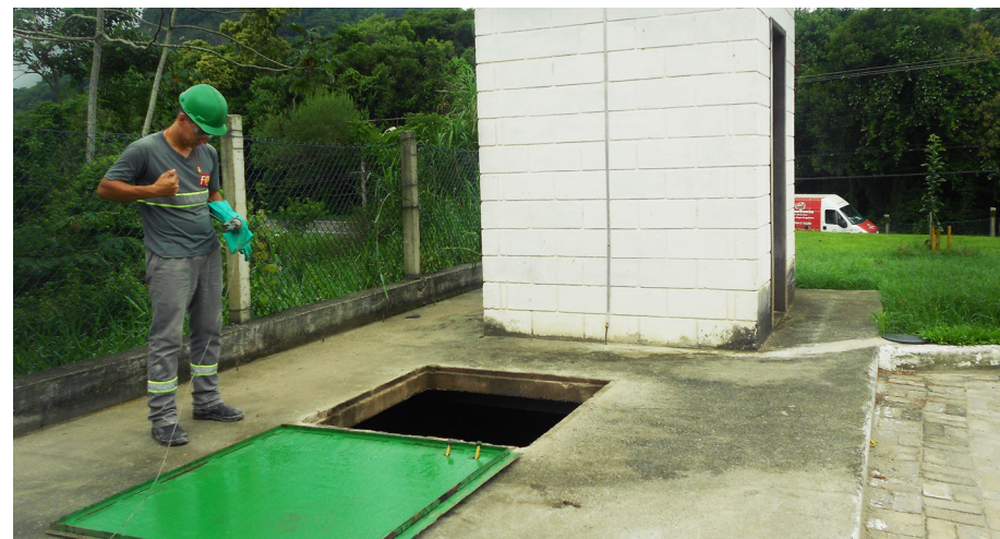
Tratamento Efluentes - Unidade Misturadora São Francisco do Sul-SC
